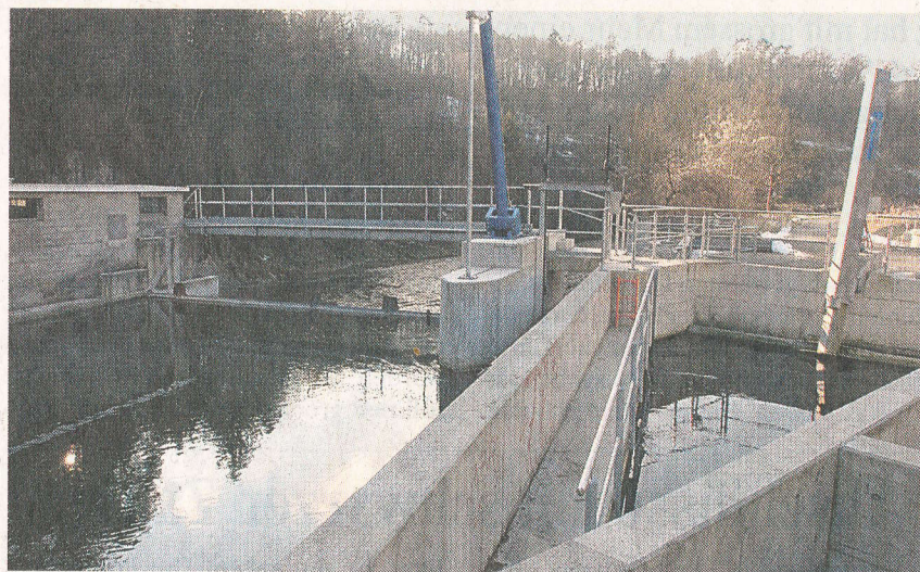
Die Prosperität des Kraftwerks hängt von der Wasserführung der Töss ab. Bild: awo
