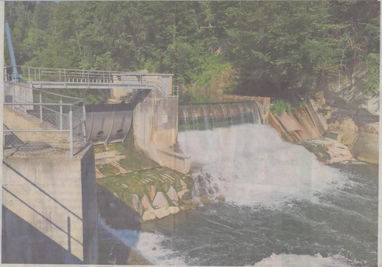
Im Kleinkraftwerk in Freienstein fliesst das Wasser zwar, aber in diesen trockenen Tagen zu wenig, um die Turbine anzutreiben.
