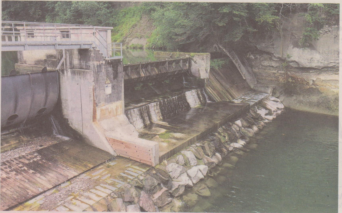
Der Prallboden des Tösskraftwerks in Freienstein musste neu betoniert werden.
